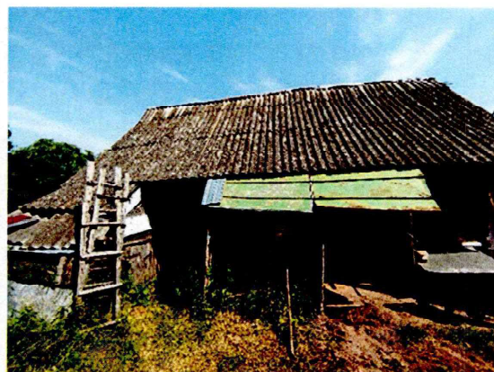
Fot. Budynek gospodarczy. Budynek wykonany w konstrukcji drewnianej. Dach dwuspadowy o konstrukcji drewnianej kryty płytami z eternitu. Wrota drzwiowe i drzwi drewniane z desek.
