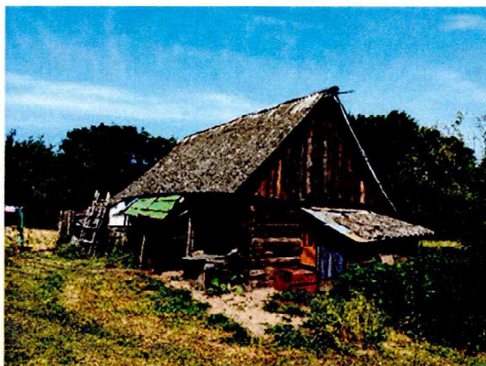
Fot. Budynek gospodarczy. Budynek wykonany w konstrukcji drewnianej. Dach dwuspadowy o konstrukcji drewnianej kryty płytami z eternitu. Wrota drzwiowe i drzwi drewniane z desek.
