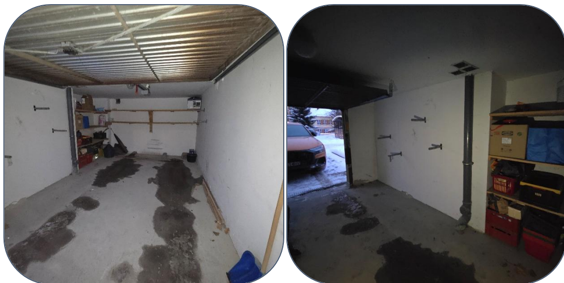
Widok na segment garażowy
