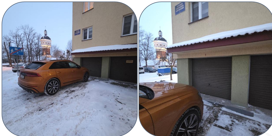
Widok na segment garażowy
